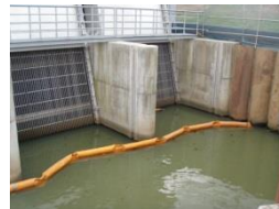
オイルフェンスの設置
