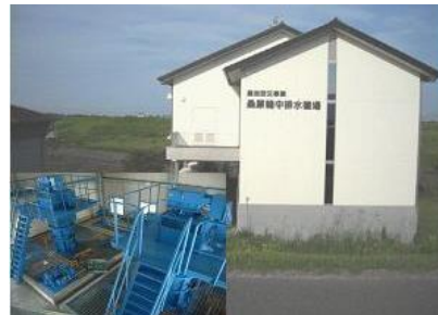
桑原輪中排水機場
