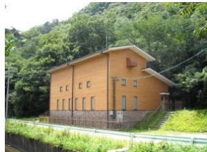
伊木山揚水機場
