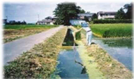
用排兼用の土水路
