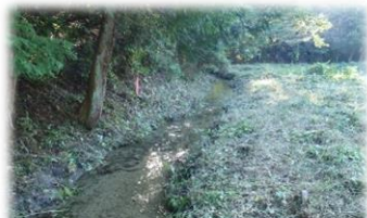
用排水兼用の土羽水路
