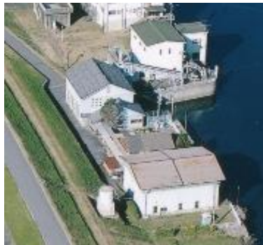
上:桑原排水機場(昭和32年度設置) 下:小藪排水機場(昭和14年度設置)
