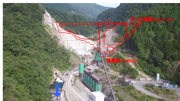
② ダムサイト状況(下流上空より望む)
