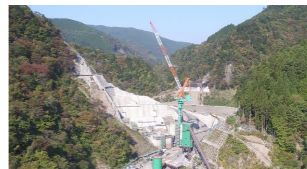
⑦ タワークレーン施工状況
