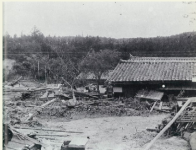
▲ 明治 37年当時の被災状況 (出典：坂本記録写真集 目で見るとの歴史 第1部)
