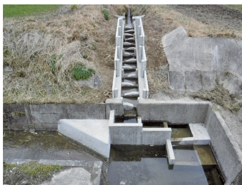
改修後（関市 千疋地区）
