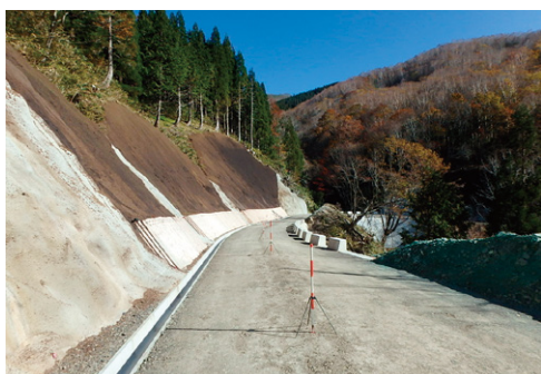
白尾～鷲見線(4-2工区) 林道開設工事
