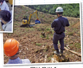
現地見学会 (リモコンで建設機械を操作します)
