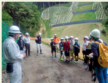
▲ 小学生を対象とした施工中の見学の様子
