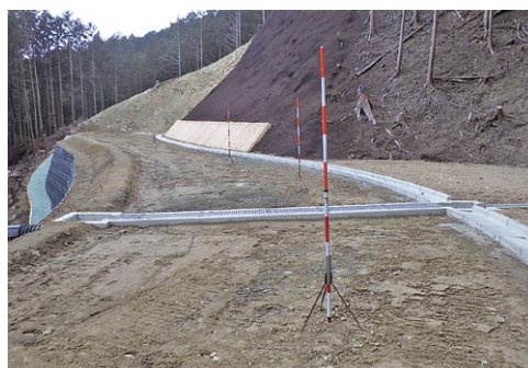
尾城線林道開設工事
