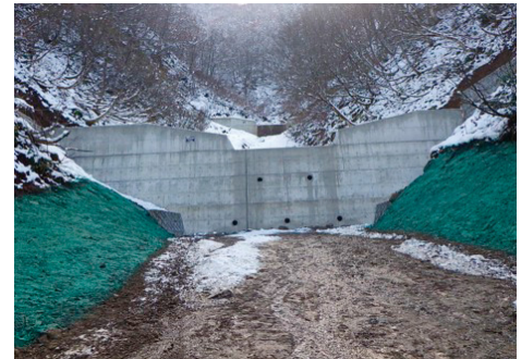
復旧治山事業 鉛谷山工事
