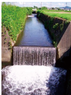
農業用排水路内の落差
