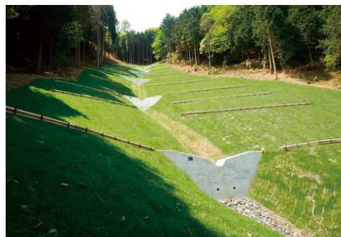
復旧治山事業 奥谷地区(補正)工事
