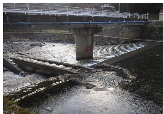
工事後 土砂撤去後 【前川(郡上市)】
