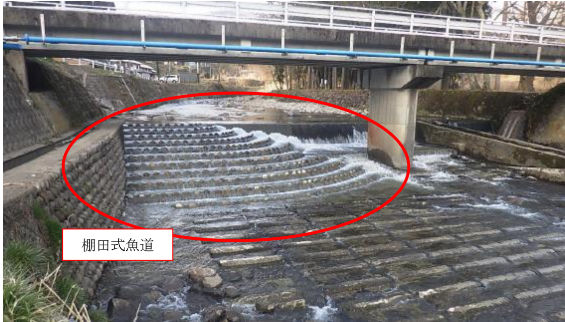
魚が遡上しやすい魚道に改修 【前川(郡上市)】
