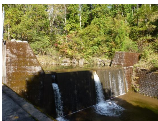
下流の取水堰堤（東白川村）
