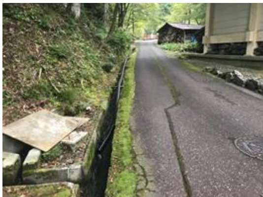
設置予定箇所
