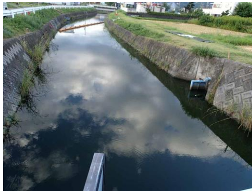
ろ過作業完了後の状況
