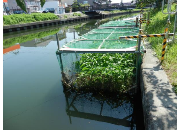
空芯菜を用いた水質浄化対策の実施（H28.6～H28.10）
