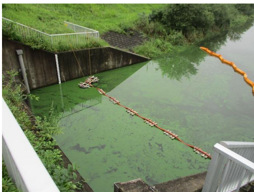
ろ過作業中の状況
