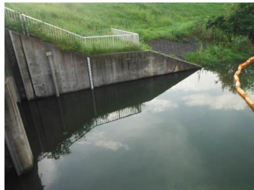
ろ過作業完了後の状況
