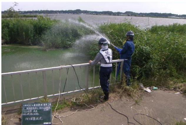
写真－15 放水による攪拌のイメージ
