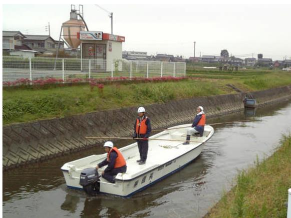
写真－16 モーターボートによる攪拌（H23 実施）
