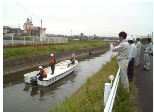
写真-10 モーターボートによる攪拌の実施状況
