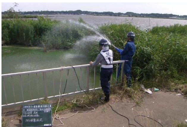
写真3 放水による攪拌（イメージ）
