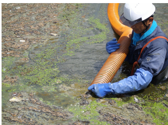
(H22.9.2 バキュームによる除去作業)
