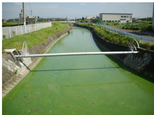
(H22.9.3 スカム除去後の状態)
