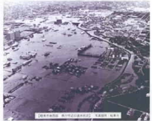
昭和51年境川 岐阜市藪田 県庁付近
