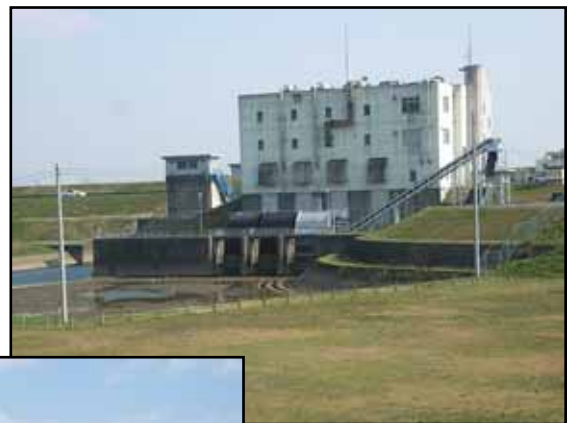
両満川排水機場
