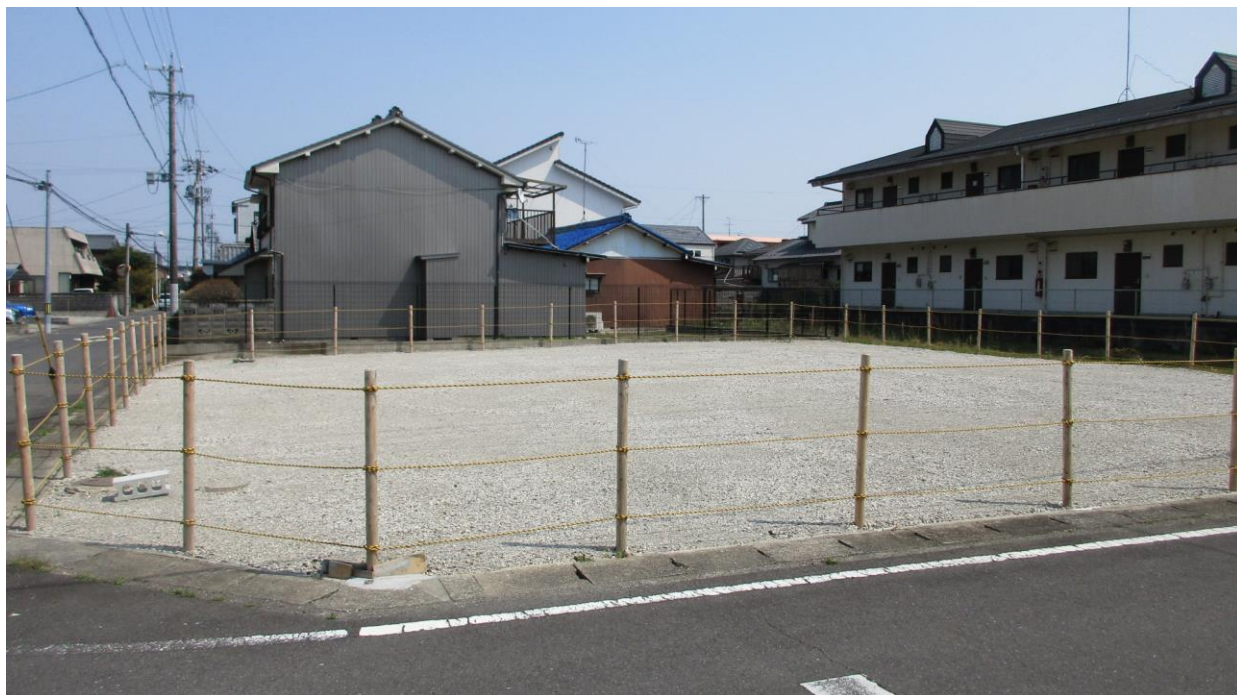
物件西方向から撮影
