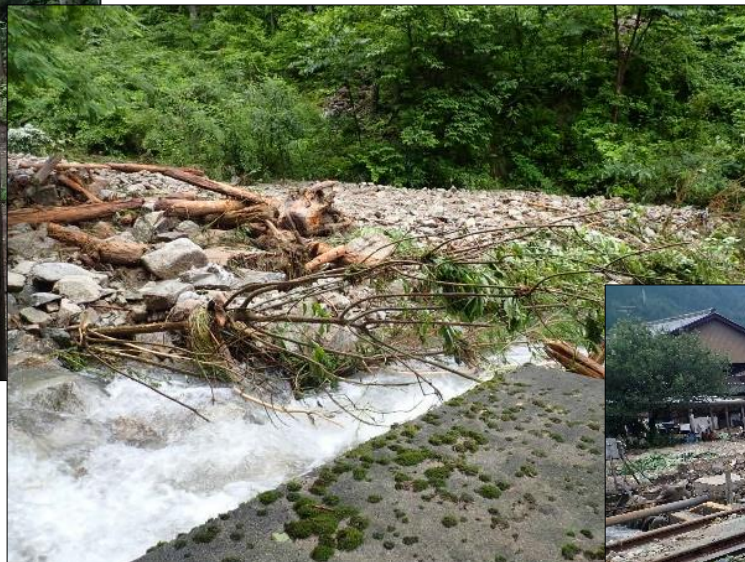
既設谷止工による土砂等捕捉
