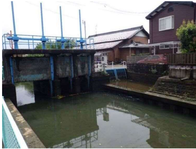
図 3-8 八島ゲート（開扉状況）
