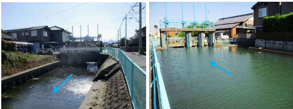
図 2-4 八島ゲートの状況
