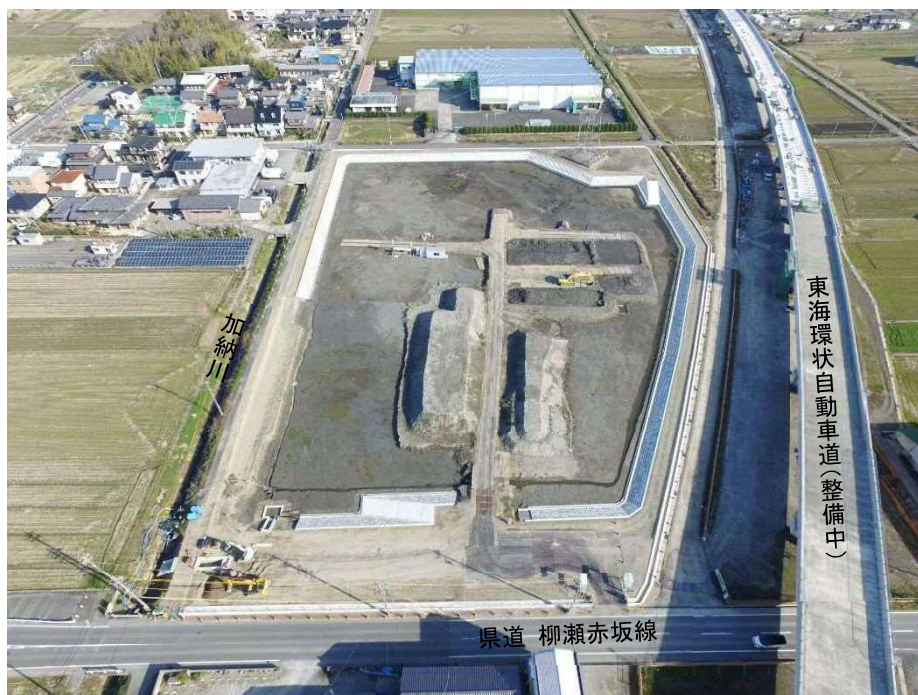
図 2-6 調節池の整備状況（平成 31 年 3 月時点）
