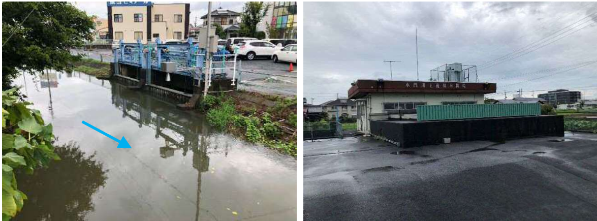
図 2-2 水門川上流排水機場
