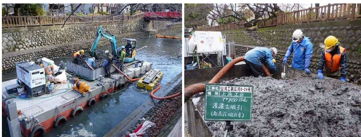
図 2-7 河床掘削状況
