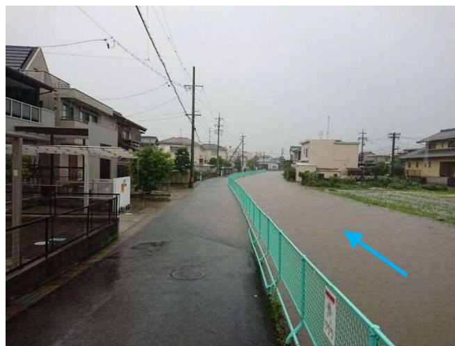
図 3-11 八島町地内の浸水状況（令和元年7月台風第5号当時）
