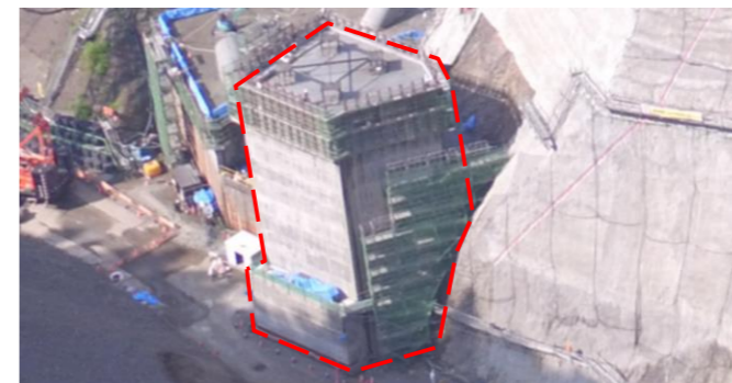
⑦ タワークレーン基礎施工状況
