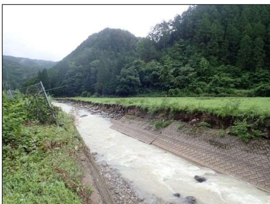
今回の大雨による西洞谷（高山市朝日町西洞地内）の砂防施設の被災事例（護岸工）
