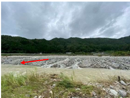
飛騨川 土砂堆積状況 (高山市久々野町地内)
