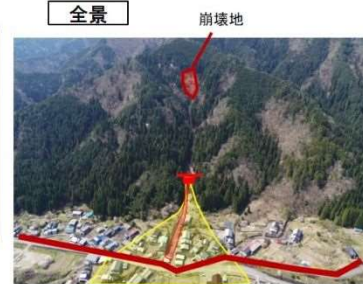
崩壊地 保全対象 人家9戸、主要地方道 白鳥板取線
