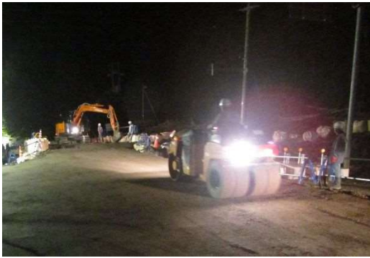
国道158号応急復旧状況（高山市丹生川町）
