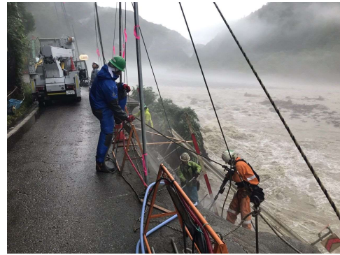
国道471号応急復旧状況（高山市上宝町）
