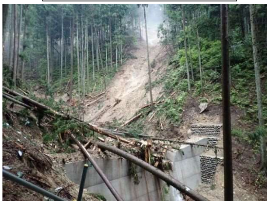
治山ダムによる土砂、流木の捕捉 (下呂市萩原町上呂門洞地内)
