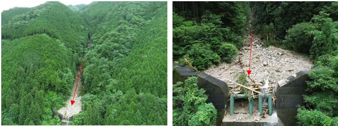
砂防堰堤の捕捉状況（クラ平谷 下呂市小坂町地内）
