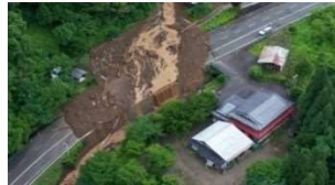
②土砂流出 (高山市・国道158号)
