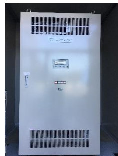
太陽光パネル 蓄電池
