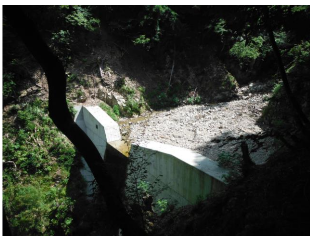
土砂流出を防ぐ治山施設（谷止工）
