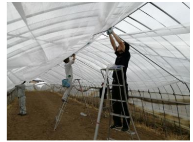
【内張で遮光資材を設置】
