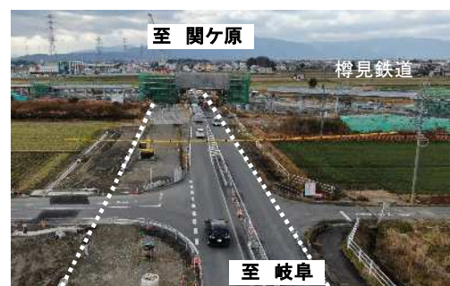
(主) 岐阜関ヶ原線 宗慶・温井Ⅱ期工区 工事状況
