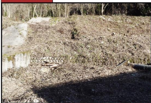
第一号砂防堰堤
