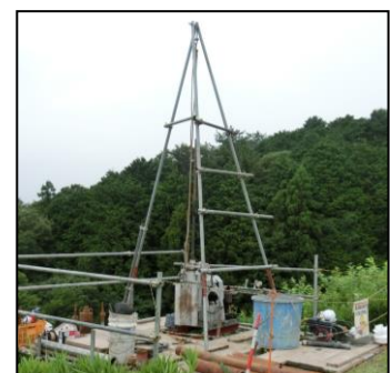
ボーリング調査 （足場仮設）
