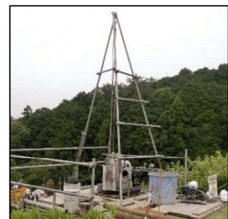
ボーリング調査 （足場仮設）
