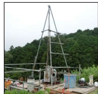
ボーリング調査 （足場仮設）
