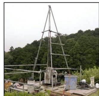
ボーリング調査 （足場仮設）
