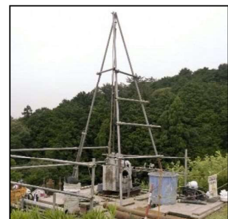
ボーリング調査 （足場仮設）
