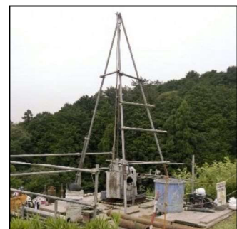
ボーリング調査 （足場仮設）
