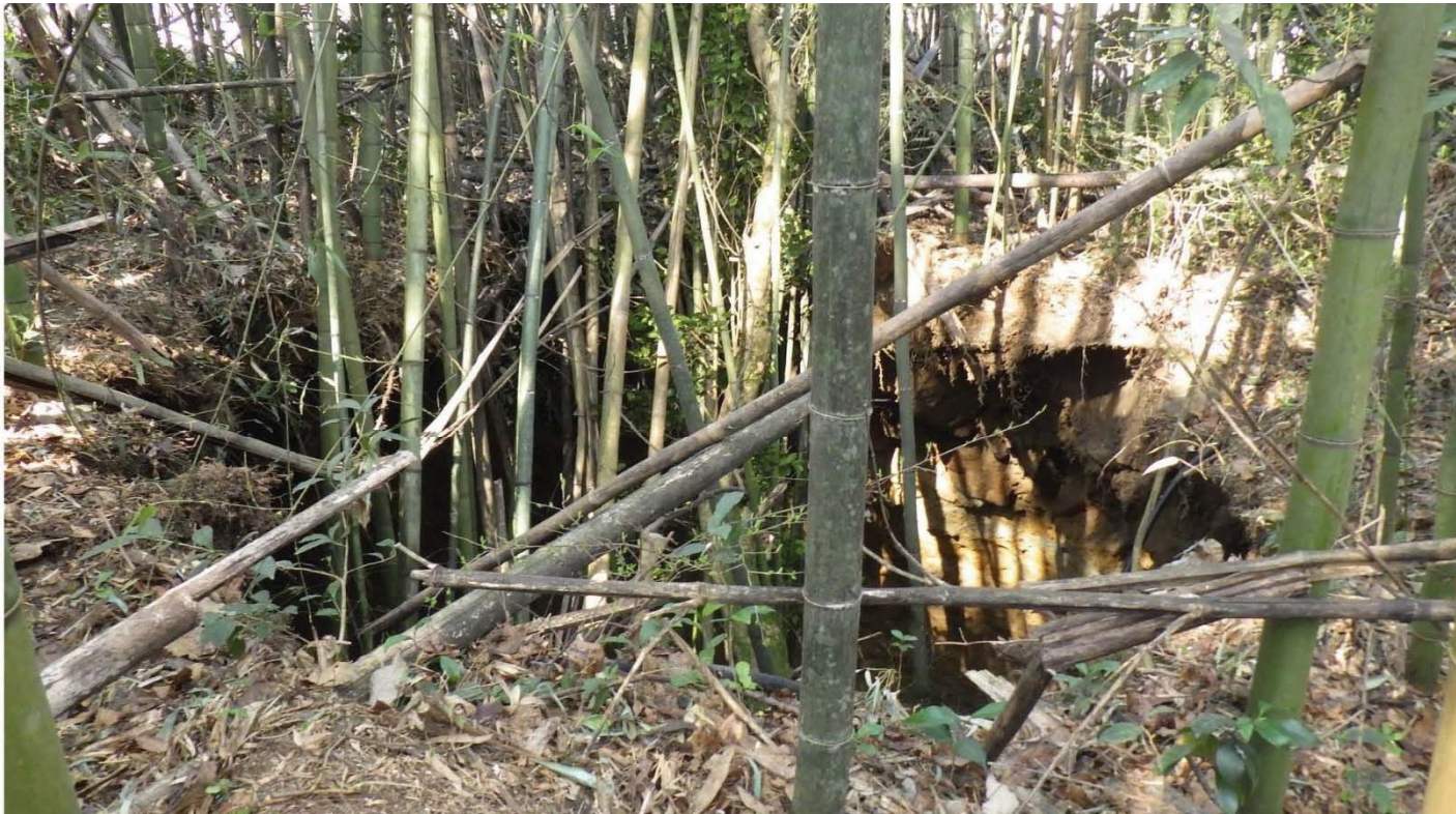
地上部土砂崩落状況 (平成31年4月8日撮影)
