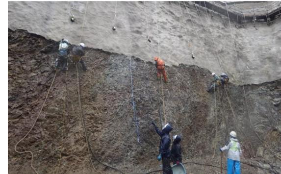
仕上げ掘削とは、基礎掘削作業の際50cm程度残した岩盤をコンクリート打設前に丁寧に掘削し、岩盤面を仕上げる作業です。
