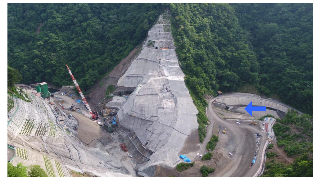
④ ダムサイト右岸状況(左岸上空より望む)
