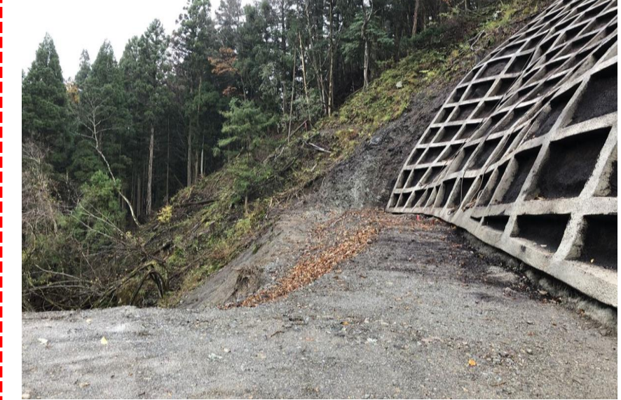
⑤ 下流工事用道路状況
