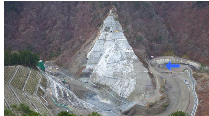
④ ダムサイト右岸状況(左岸上空より望む)
