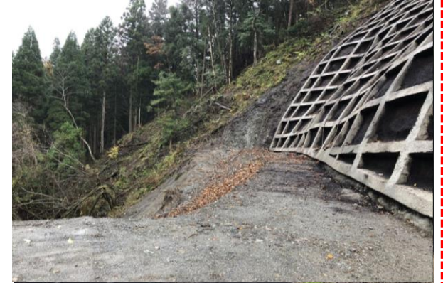
⑤ 下流工事用道路状況
