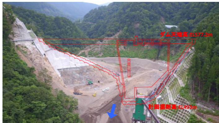
② ダムサイト状況(近景:下流より望む)
