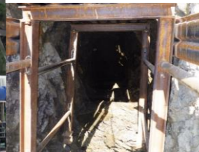
⑧ 調査横坑の内部
