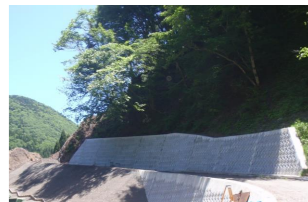
⑤ 下流工事用道路状況
