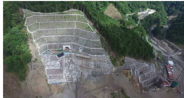
③ ダムサイト状況(右岸上空より望む)
