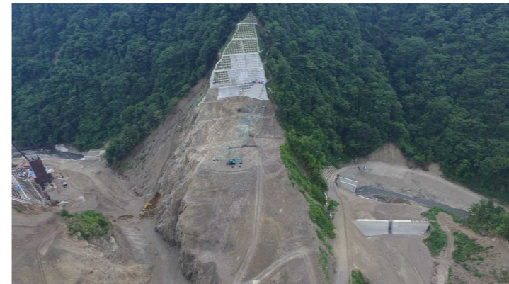
④ ダムサイト状況(左岸上空より望む)
