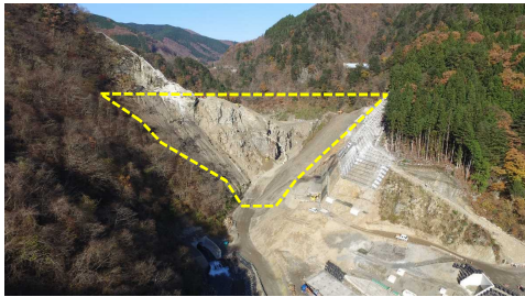
① ダムサイト状況(遠景:下流上空より望む)
