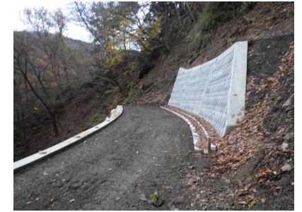
⑤ 下流工事用道路状況
