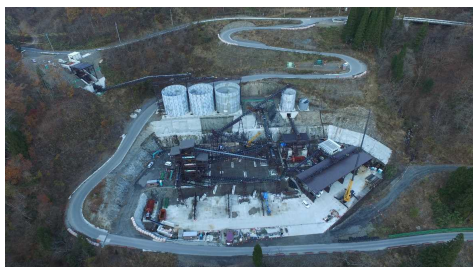
⑥ 骨材プラント状況(上空より望む)
