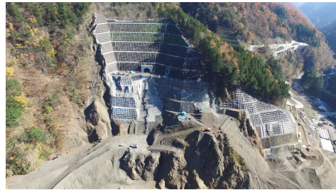
③ ダムサイト状況(右岸上空より望む)
