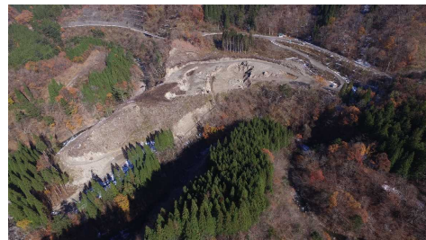
⑦ 原石山状況(上空より望む)
