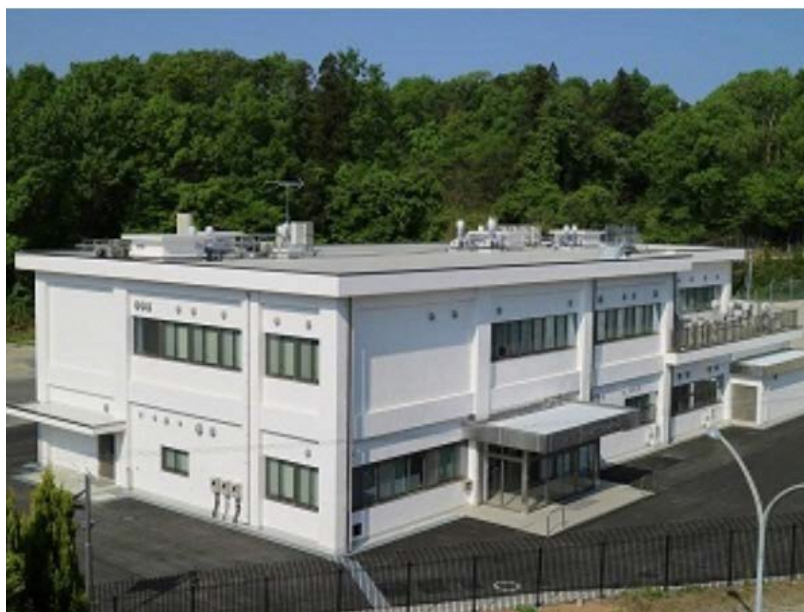
岐阜県東部広域水道事務所 水質試験棟
