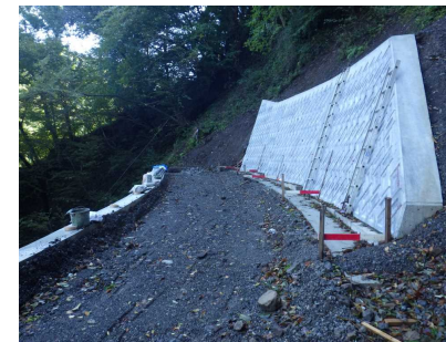
⑤ 下流工事用道路状況
