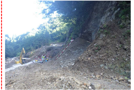
⑤ 下流工事用道路状況
