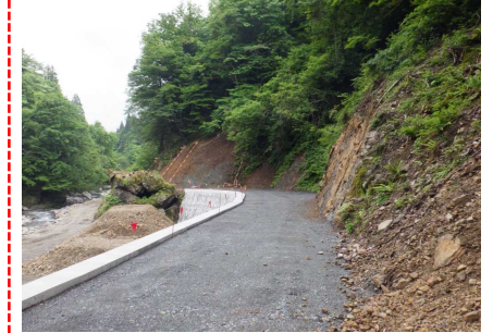
⑤ 下流工事用道路状況
