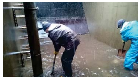
上水槽清掃状況
