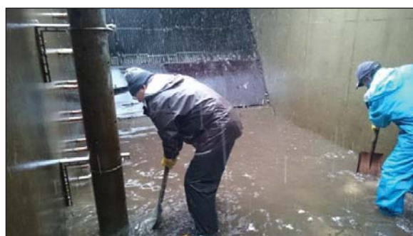
上水槽清掃状況
