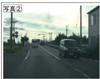
JR東海道本線の踏切を望む
