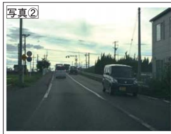
JR東海道本線の踏切を望む
