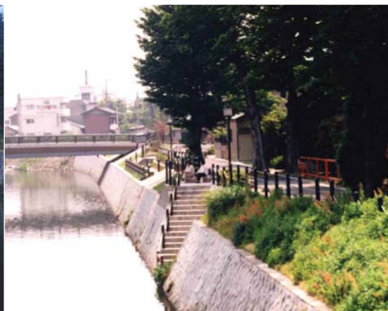
加納大橋と階段護岸
