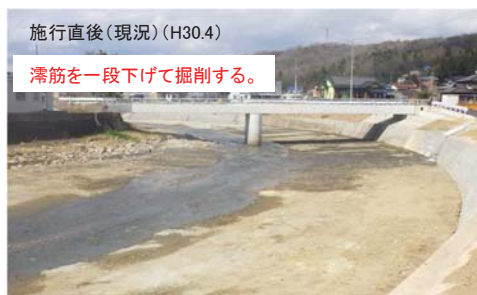
河床に多様性をもたせた掘削状況(石仏橋付近)
