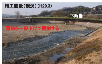
河床に多様性をもたせた掘削状況(大正堰上流付近)
