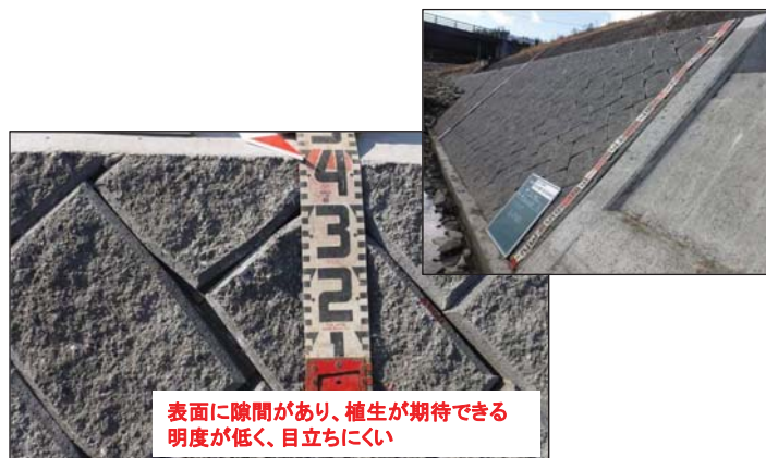
自然環境に配慮した護岸の状況(大正堰上流付近)
