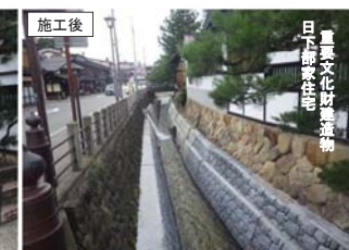
既存の石積に合わせた表面形状の根継工を設置し 景観との調和を図る
