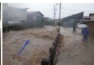
愛宕橋下流の浸水状況 H26年8月17日洪水
