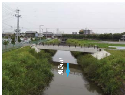
事業実施箇所(7.0km付近)
