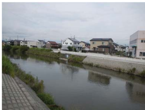
自然環境に配慮した護岸の状況(境川橋上流付近)
