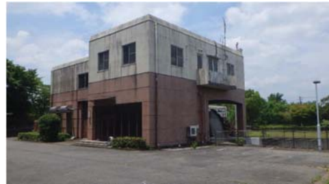
【山田川排水機場】
