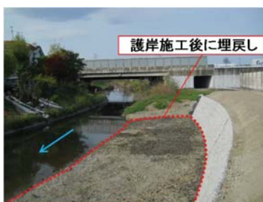
施工直後の状況(H25)
