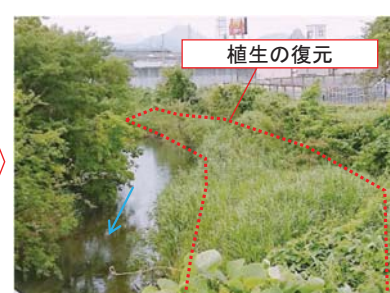
施工後6年経過(R1)
