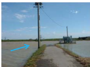
ハリヨ橋上流の浸水状況 平成16年10月20日洪水
