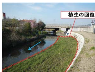
施工後1年経過(H26)
