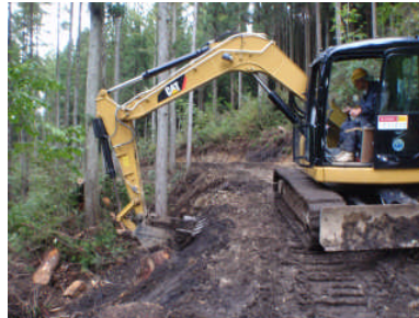
伐根を利用した路肩補強
