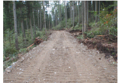
敷き均し状況
