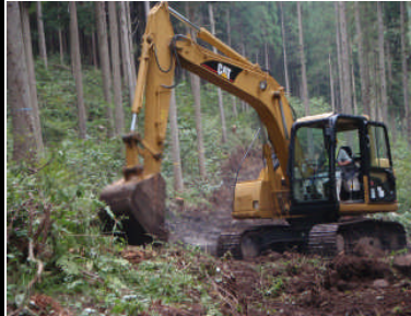
作業路開設状況
