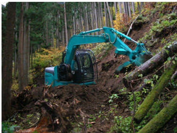
作業道の開設状況
