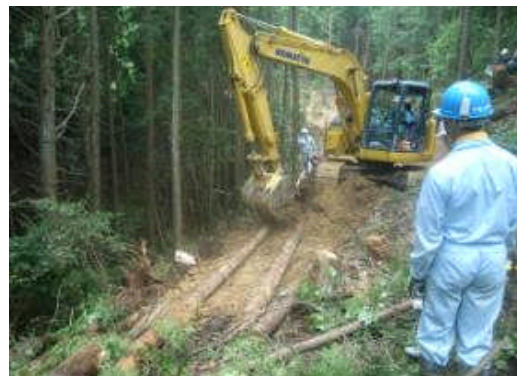
図-2 開設状況(丸太組み)
