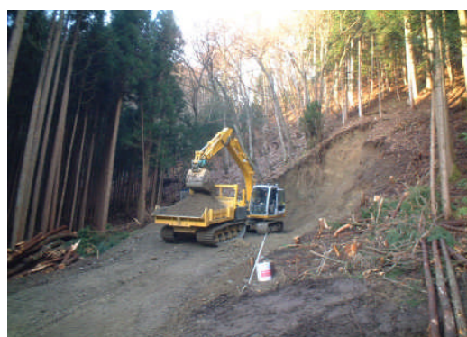
山土砂による安定基盤の確保
