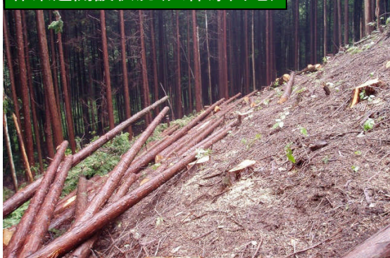
作業道開設状況(久保原団地)
