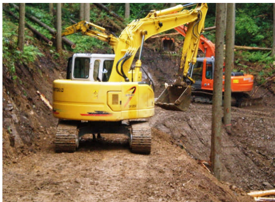
バケットによる転圧
